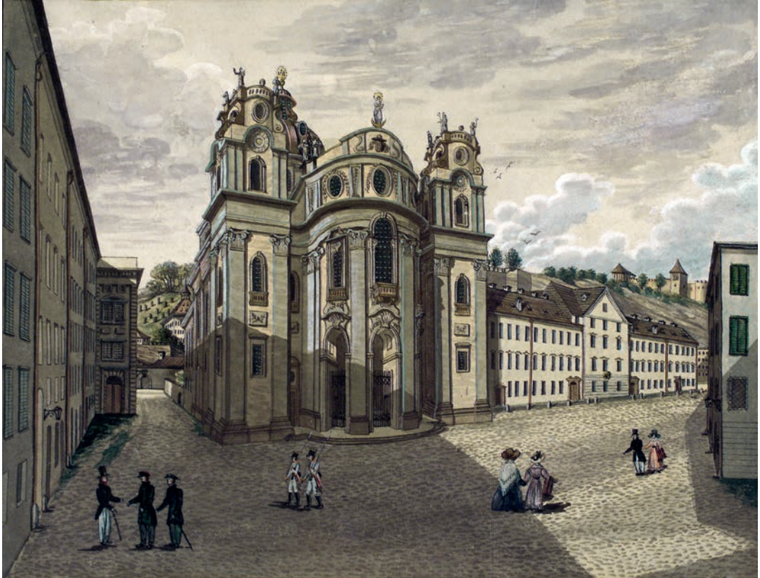
Abb. 5: Franz von Kurz schuf 1829 dieses Aquarell der nunmehrigen Lyzealkirche, auf den Zifferblättern sind keine Zeiger zu sehen. Der Balken zwischen dem rechten Turm und dem Mittelteil oberhalb des Zifferblatts trägt vermutlich die Minutenwelle, die vom Uhrwerk im rechten Turm zu den Zifferblättern im linken Turm führte?
