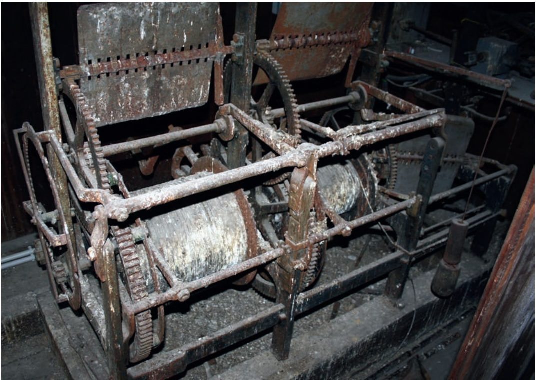
Abb. 13: Das Turmuhrwerk Kollegienkirche im Draufblick
